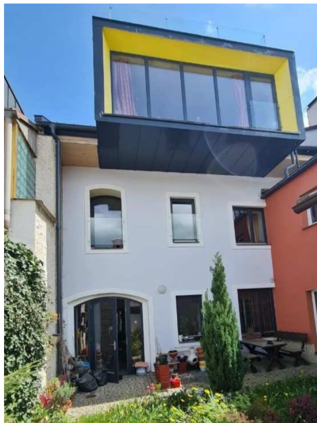
Pohled z ulice Tyršova, pohled ze dvora (foto RK)
