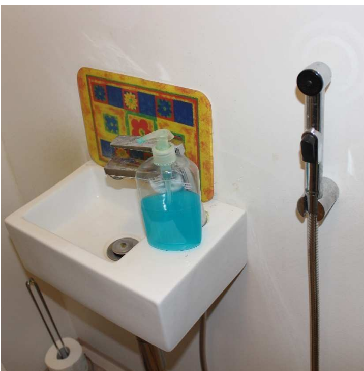
Samostatné wc (2.NP)
