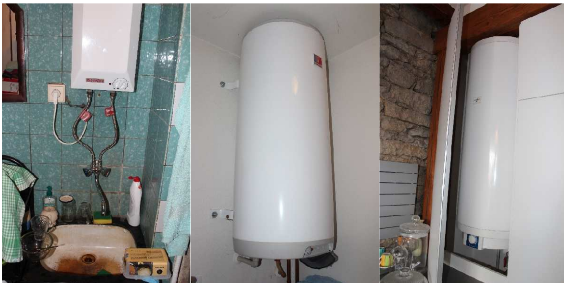
Průtokový ohřívač v 1.NP, zásobníkové ohřívače ve 2 a 3.NP
